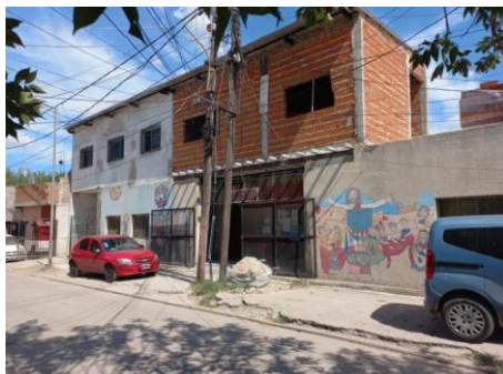
Neubau der Schule Francisco Solana
